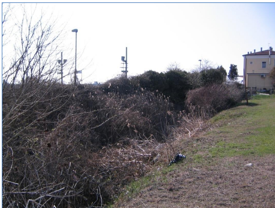
Fossato laterale alla linea ferroviaria esistente sul margine Sud dell'area in variante
