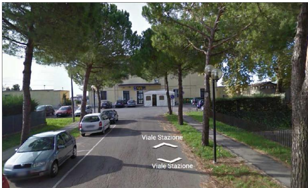
Vista della stazione ferroviaria da Viale Stazione (estratto da Google Maps)
