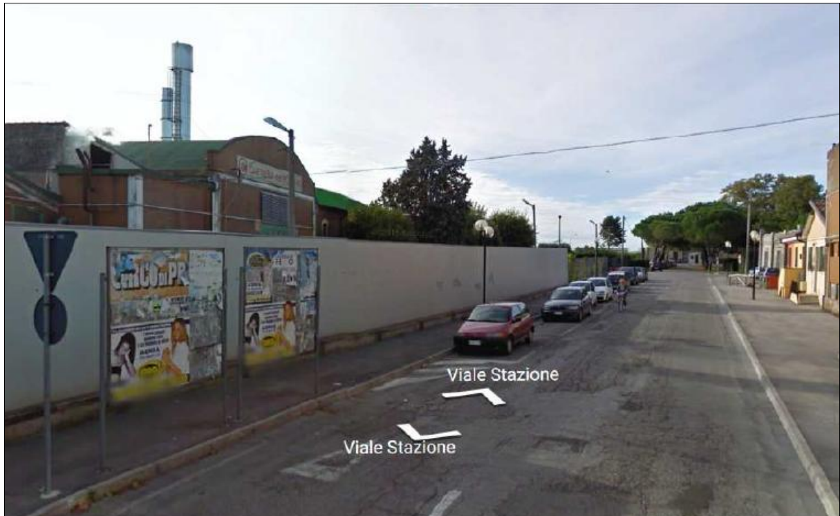
Vista della recinzione ovest dell'impianto lungo Viale Stazione (estratto da Google Maps)
