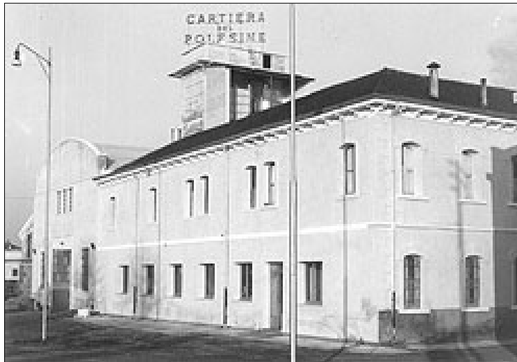
Vista dello stabilimento originario
