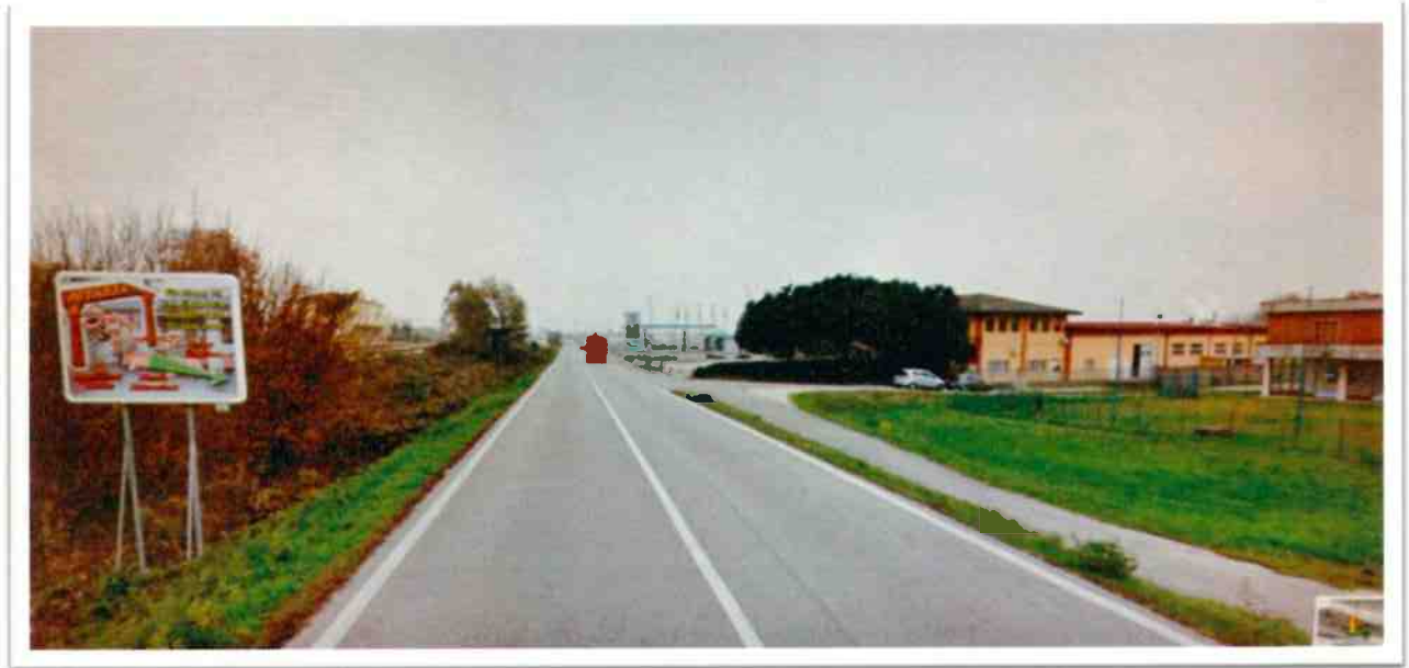
01 - Strada Provinciale n. 45
