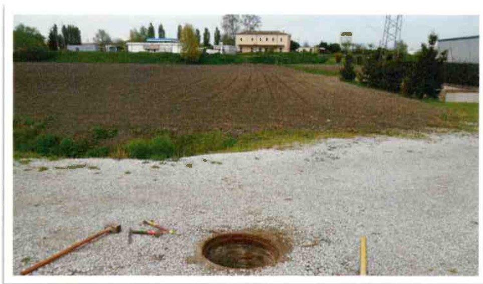
07 - Vista da Via Diana verso la Strada Provinciale n. 45
